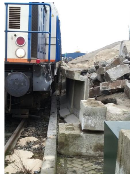
Aanrijding (oude) perronwanden (foto: VolkerRail)
