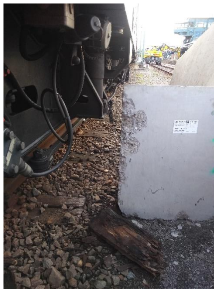
Aanrijding ankerblok (foto: Strukton Rail)
