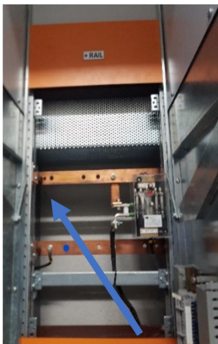
Foto 1 Ontbrekende aardverbindingen
