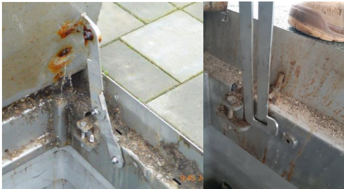
Afbeeldingen 4 en 5. Borging van de deksel
