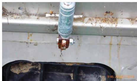
Afbeeldingen 2 en 3. Gasveer (deksel in open stand)
