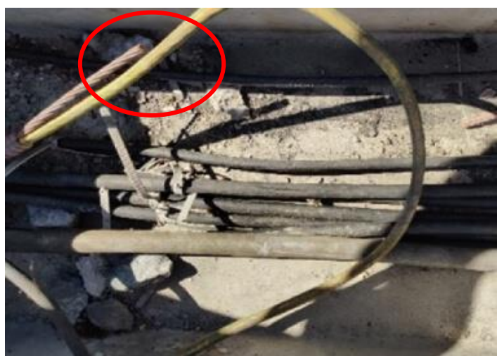
Geknipte kabels in een kabelkoker
