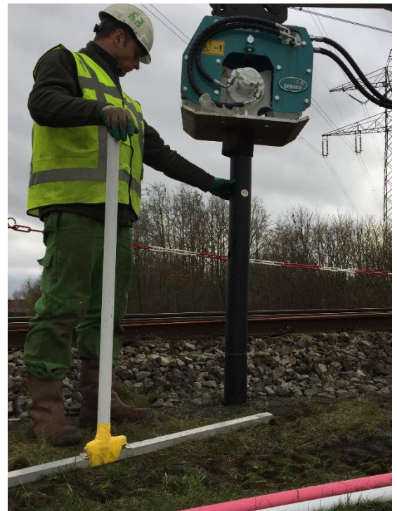
Afbeelding 6 – Intrillen van de kunststof standers
